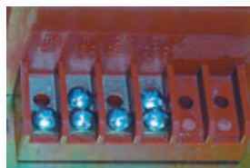
Sekundární svorkovnice (2 sekundární vinutí a uzemňovací šrouby)
